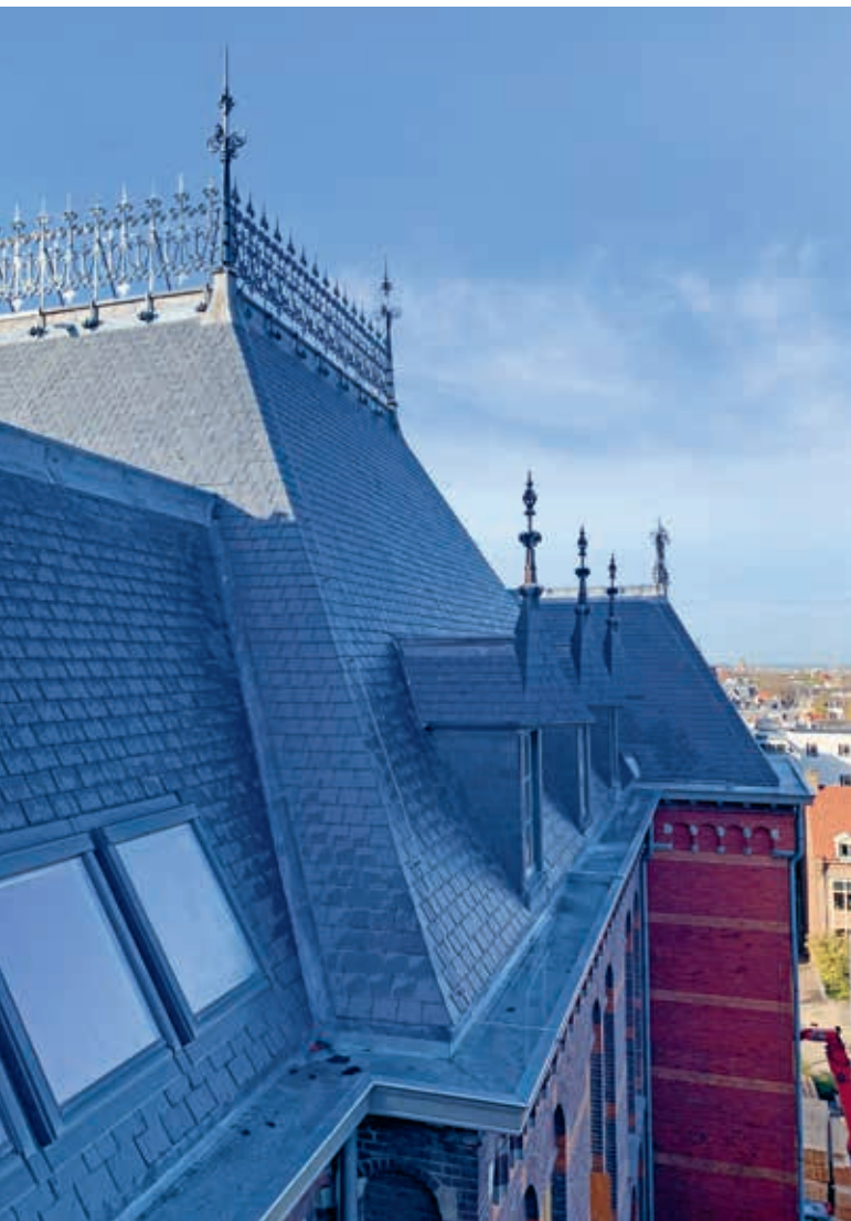
Het dak heeft sierhekwerk en dakkapellen met pinakels.
